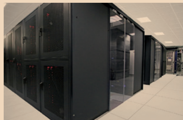
Riel è specializzata in inside plant
